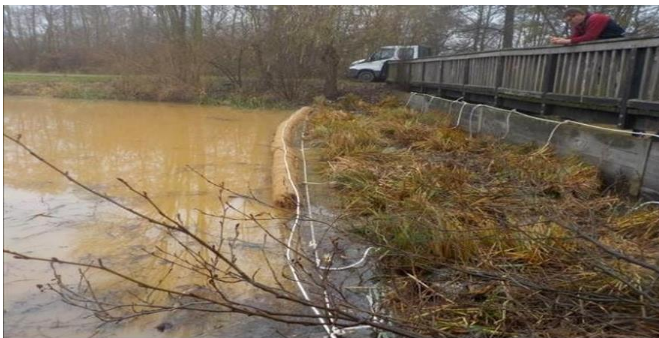
Plovoucí rákosové ostrovy AquaGreen® v kombinaci se vztlačovým válcem AquaGreen®, který působí jako ochrana proti náplavám.
